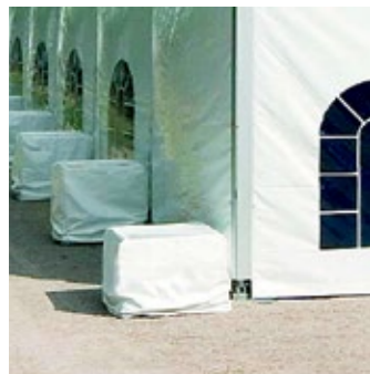
Anclaje de peso mediante bloques de hormigón
