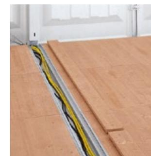
Sistema de suelo flotante con canales integradas para el paso de instalaciones
