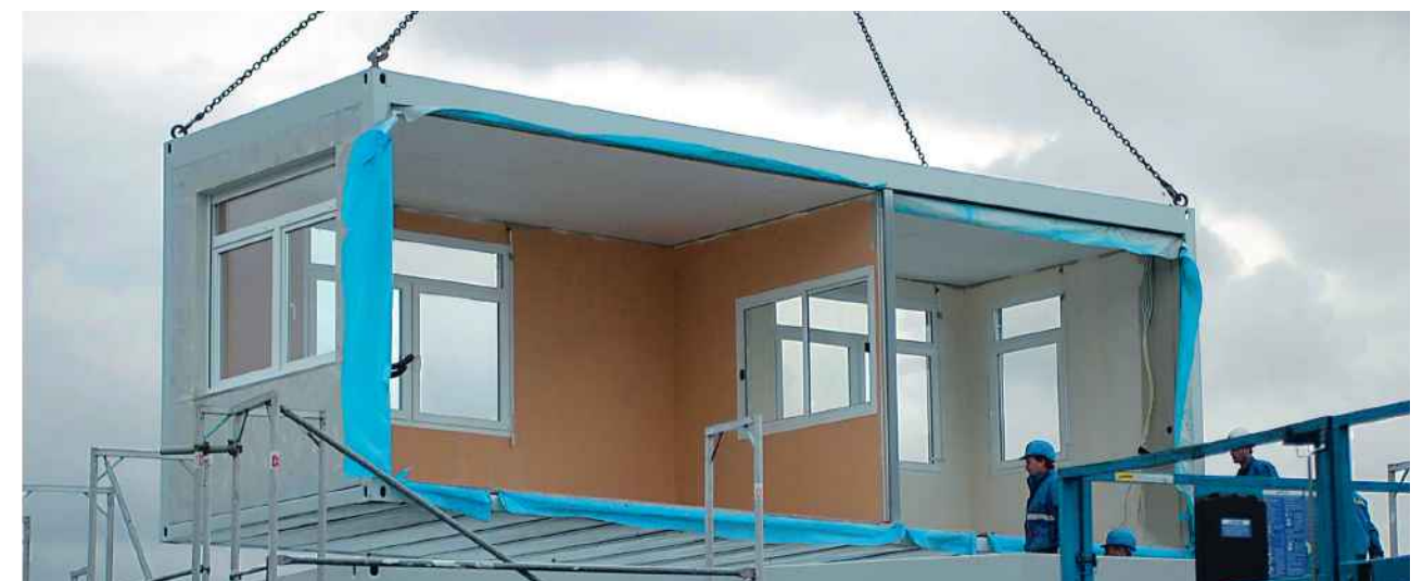
Ein Raum-Modul wird eingepasst
