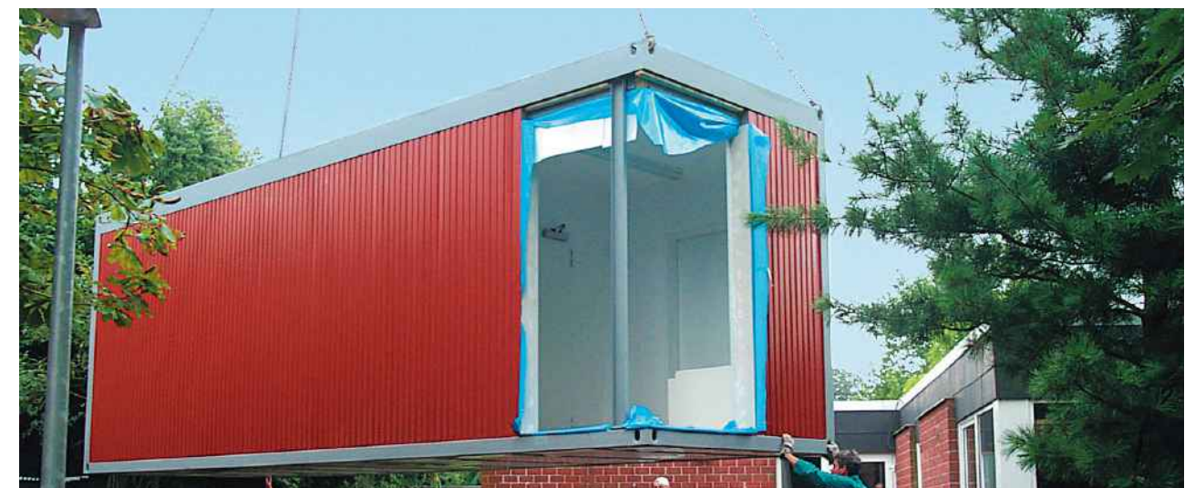
Keine Störung des Kindergartenbetriebs bei der Erweiterung
