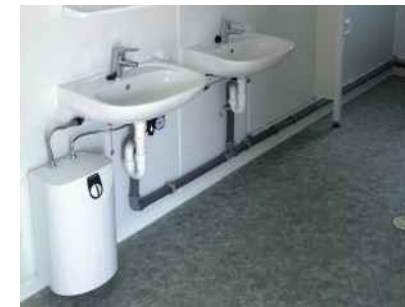
Waschbecken mit Durchlauferhitzer
