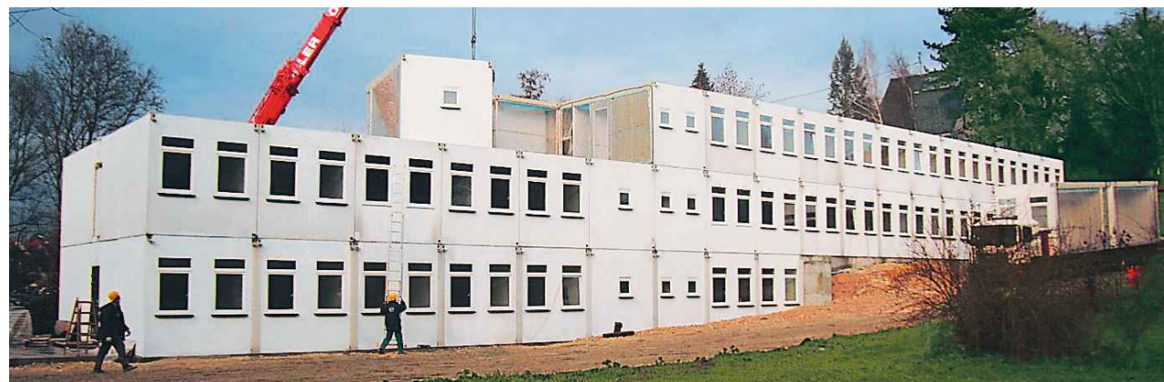
Präzise Arbeit mit dem Autokran
