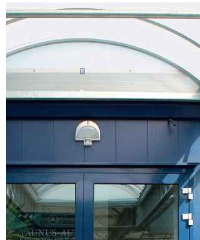
Eingangstüre mit Vordach
