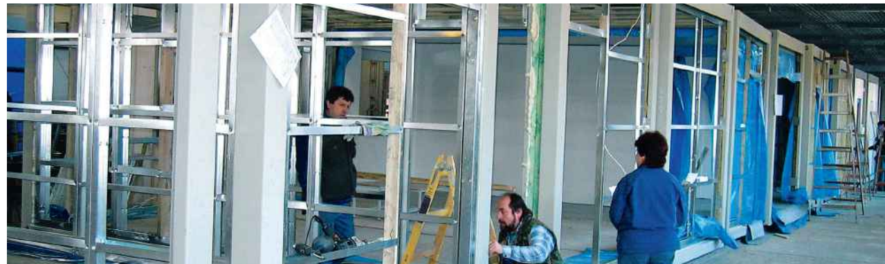
Vorfertigung im Werk
