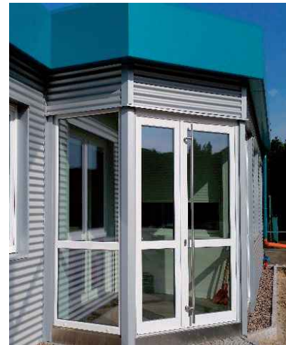
Eingang als Vorbau
