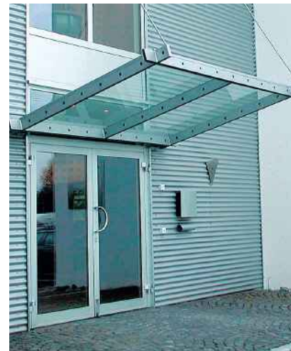
Eingangstüre mit Vordach
