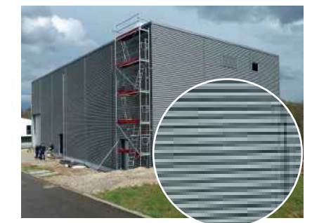
Sinuswelle mit Lisene abgedeckt
