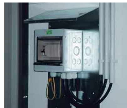
Ex-Sicherungskasten
