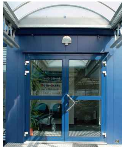
Eingangstüre mit Vordach
